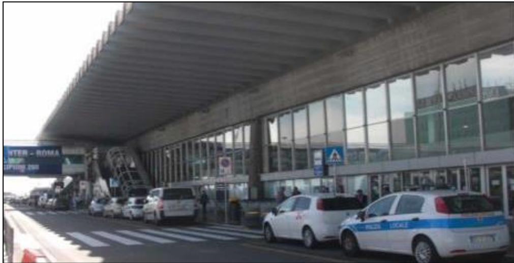
2015: esterno T3 prima dell'avvio dei lavori di riqualifica della facciata
