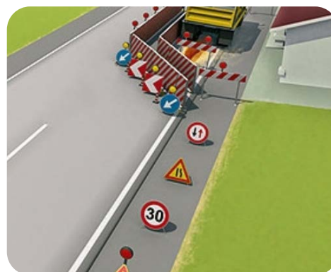
Figura 9 - Segnaletica provvisoria di cantiere
