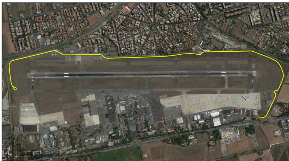
Ciampino, strada perimetrale
