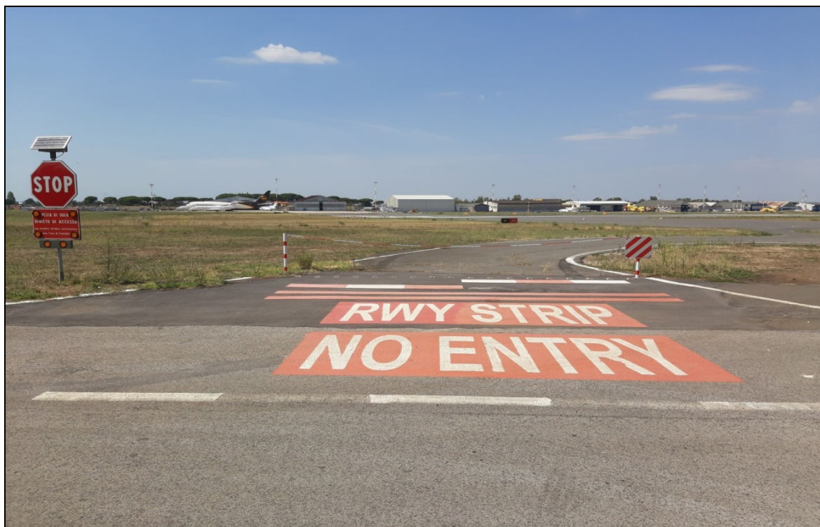
Figura 17- Segnaletica di ingresso in pista delle strade sulla perimetrale di Ciampino
