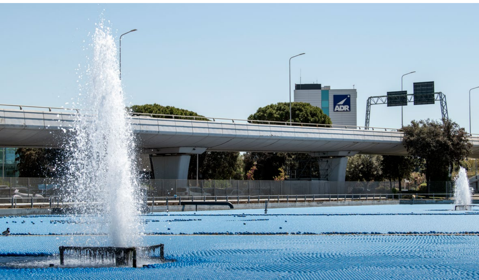
Riserva idrica di acqua industriale dell'aeroporto Leonardo da Vinci
