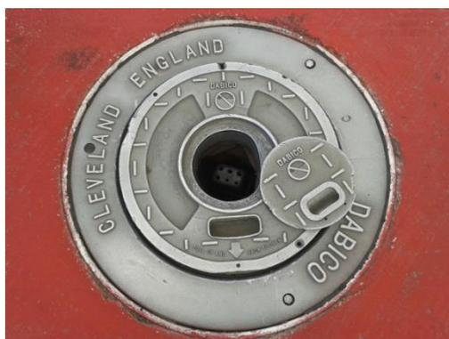
Figura 1 - Pozzetto 400 Hz
