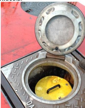
Figura 9 - Pozzetto 400 Hz con colonna all'interno
