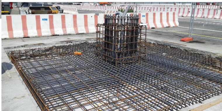
Realizzazione nuovo basamento torre faro
