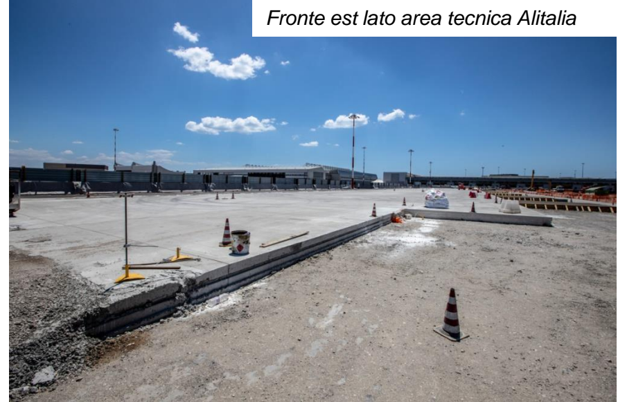
Fronte est lato area tecnica Alitalia
