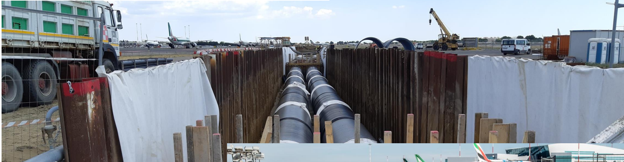
Nuovo collettore – alloggiamento collettori attraversamento Taxiway AG
